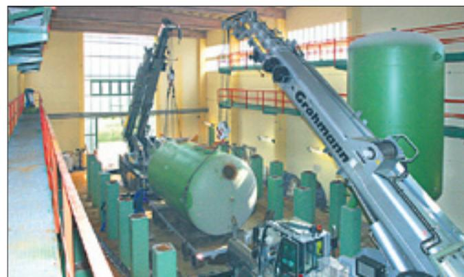
Zentimeterarbeit – zwei Kräne hieven den mehrere Tonnen schweren Filterkessel in die Horizontale.
