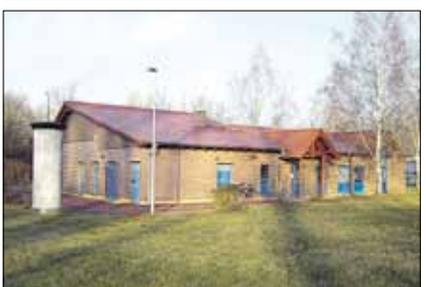
Auf dem Gelände des Gubener Hauptpumpwerks stand früher die mechanische Kläranlage. Heute werden hier sämtliche Abwässer aus dem Entsorgungsgebiet I (GWAZ-Altverband) gesammelt und über zwei Dükerleitungen, die unter der Neiße hindurchlaufen, ins Klärwerk nach Gubin (Republik Polen) transportiert. Monatlich sind dies zwischen 100.000 und 120.000 m<sup>3</sup> – also beinahe eine Million Baderfüllungen.
