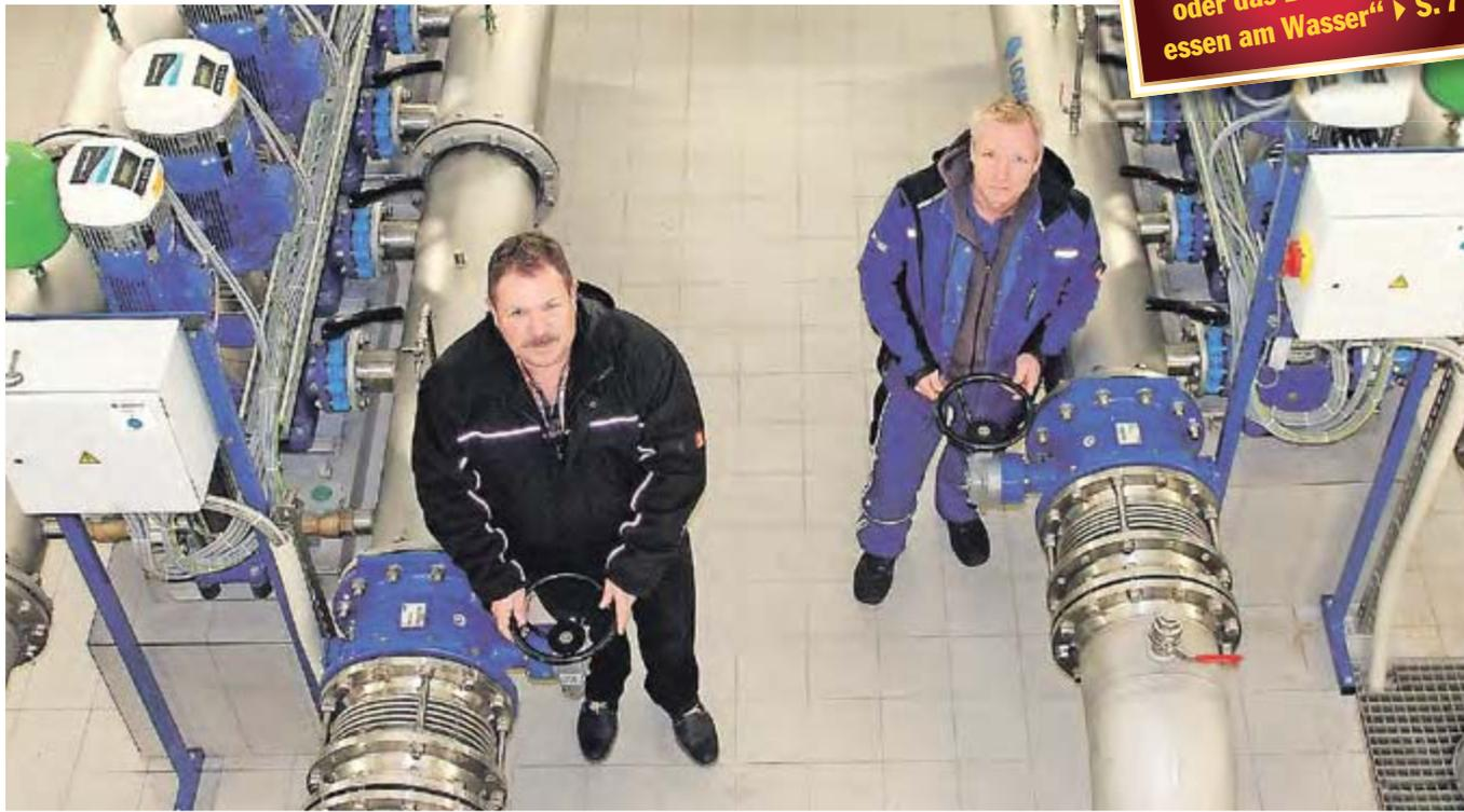
Steffen Kusch (r.), Teamleiter Produktion Trinkwasser, und Steffen Buckel-Ehrlichmann, GWAZ-Planungsingenieur, zwischen den Wasserpumpen im Inneren der neuen Druckerhöhungsstation Sprucke. Sie hebt den Wasserdruck in den ausgehenden Rohrleitungen auf ein höheres Niveau.
