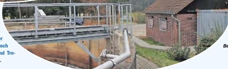
Die kleinste Anlage steht in Wellmitz. Es handelt sich hier um eine sogenannte Einbeckenanlage. Alle Reinigungsstufen finden in diesem einen Becken statt.
