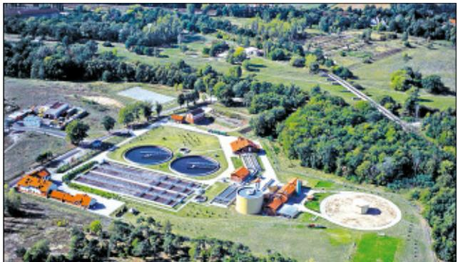
An die Abwasserbehandlungsanlage Gubin / Guben – wie sie offiziell heißt – sind mehr als 40.000 Menschen angeschlossen. Jährlich reinigt die Anlage rund 3 Mio. m<sup>3</sup> Abwasser. Mit der Anlage wird die Schadstoffbelastung der Neiße jährlich um rund 265 Tonnen Stickstoff und 50 Tonnen Phosphor reduziert. Damit leistet sie einen herausragenden Beitrag für den Schutz der Umwelt in der gesamten Neiße-Region.
