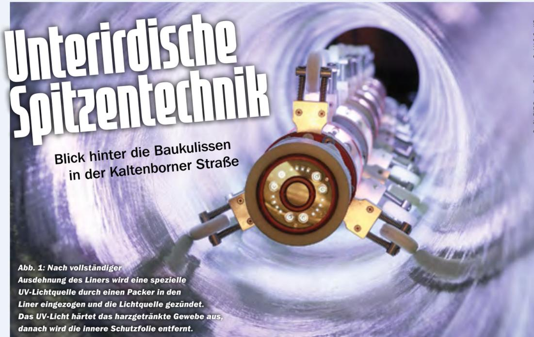
**Abb. 1: Nach vollständiger Ausdehnung des Liners wird eine spezielle UV-Lichtquelle durch einen Packer in den Liner eingezogen und die Lichtquelle gezündet. Das UV-Licht härtet das harzgetränkte Gewebe aus, danach wird die innere Schutzfolie entfernt.**
